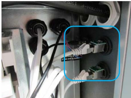
Abbildung 57 c: USB Anschluss IBC SolStore Li Innenseite Gehäuse
