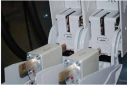
Abbildung 19: Darstellung der korrekt eingelegten Sicherungen
